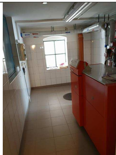
FOT. 20 – Pomieszczenie w piwnicy
