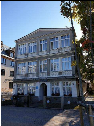
FOT. 9 – Elewacja północna
