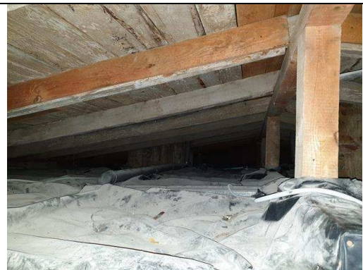
FOT. 50 – Konstrukcja więźby dachowej
