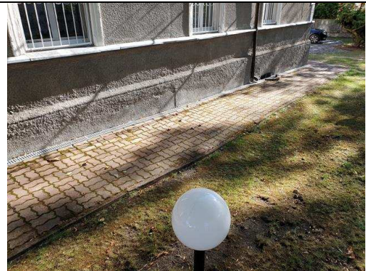
FOT. 14 – Zapadnięty polbruk przy budynku
