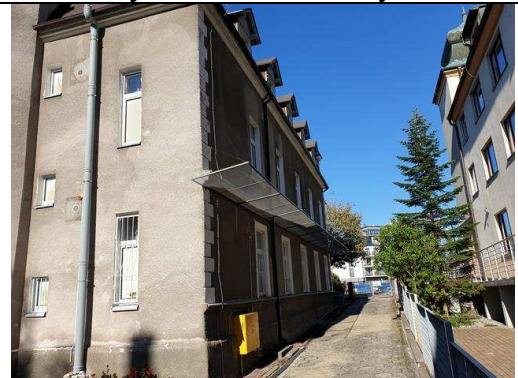
FOT. 6 – Narożnik elewacji południowej. Na zdjęciu widoczna siatka zabezpieczająca
