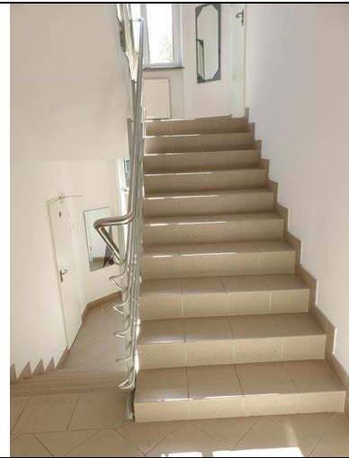
FOT. 38 – Żelbetowa bieg schodowy prowadzący na II piętro
