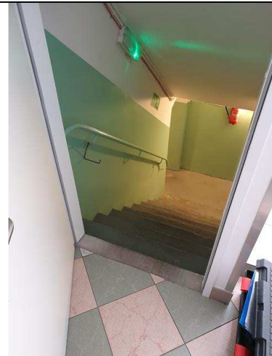
FOT. 16 – Schody żelbetowe prowadzące do piwnicy
