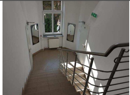
FOT. 46 – Żelbetowy bieg schodowy biegnący z I piętra na II piętro
