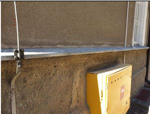
FOT. 7 – Zarysowania na elewacji
