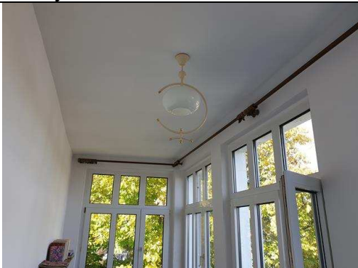
FOT. 41 – II piętro, fragment stropu odcinkowego od strony północnej
