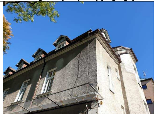
FOT. 12 – Elewacja Zachodnia. Odpadające fragmenty gzymsu
