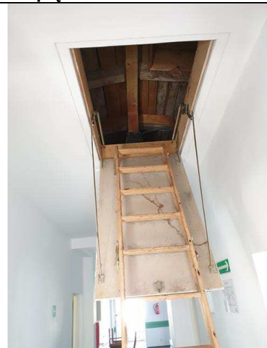
FOT. 48 – drabina wejściowa na poddasze
