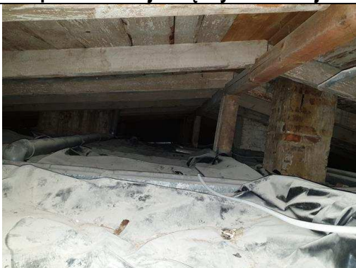
FOT. 53 – Konstrukcja więźby dachowej
