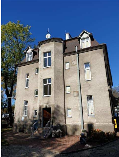
FOT. 1 – Elewacja południowa budynku
