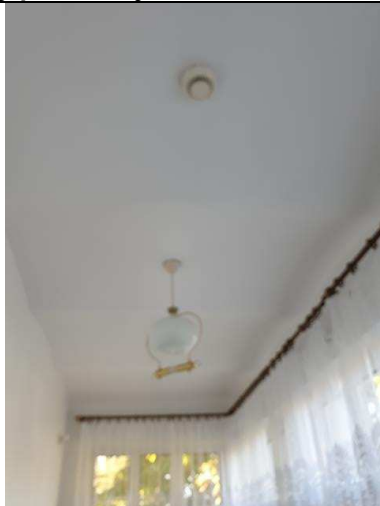
FOT. 27 – I piętro, fragment stropu odcinkowego od północy
