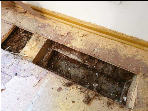
FOT. 45 – II piętro, j.w.
