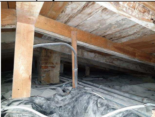
FOT. 51 p Konstrukcja więźby dachowej
