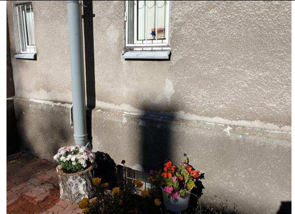
FOT. 2 – Zarysowania na elewacji
