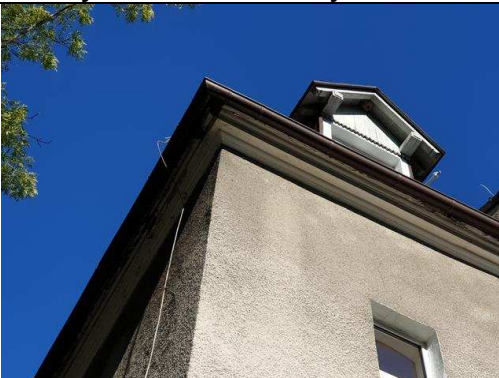
FOT. 5 – Odpadające fragmenty gzymsu
